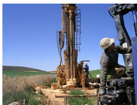
Fotos 1 y 2- Vistas de la perforación de investigación con rotoperusión del sondeo MONTALBO-2 y MONTALBO-3.
