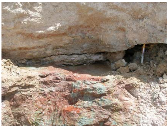
Fotos 4 y 5.- Surgencia observada en la zona de construcción.
