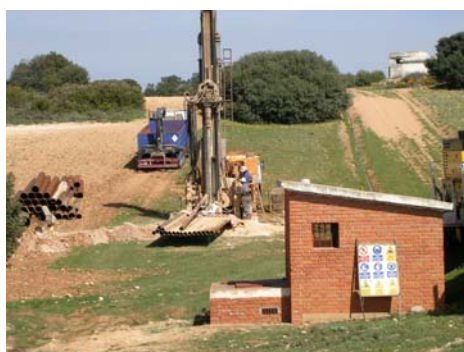
Fotos 1 y 2- Vistas de la perforación de investigación con rotoperusión del sondeo MONTALBO-2 y MONTALBO-3.
